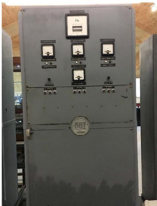
Armario de control de los vibradores de la sirena. Mediante un destellador eléctrico de corriente continua y contactos secos, una rueda de características y un interruptor de mercurio, para regular la velocidad, se producía la característica sonora de esta sirena, correspondiente a la letra b en el alfabeto morse.
