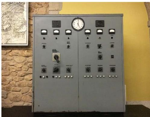
Armario general de maniobra y control para distribución eléctrica y encendido del faro. Instalado en 1963 y sustituido en 1993)
