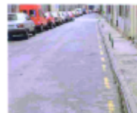
Marca amarilla longitudinal discontinua
