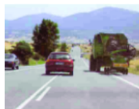
Marcas longitudinales continuas adosadas a discontinuas
